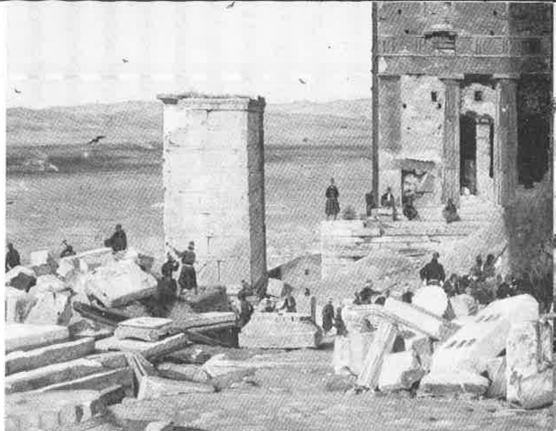
Martinus Rörbye avbildar här grekiska arbetare framför de igenmurade 'Propyleerna' som frilägges. (1835) T.v. Nike-Templets sockel, i förgrunden byggnadsfragment i marmor vilka sorterades och återfick sina rätta platser.
