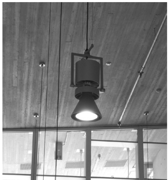
Kuva 4. Kirjaston ylimmän kerroksen pelkistetty alakatto.
